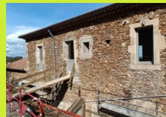
Les travaux de démolition ont débuté fin 2023. Depuis janvier une partie du gros œuvre est réalisé (dalle porteuse, démolition de l'ancien escalier, agrandissement des ouvertures), en avril pose des menuiseries et cloisons.
